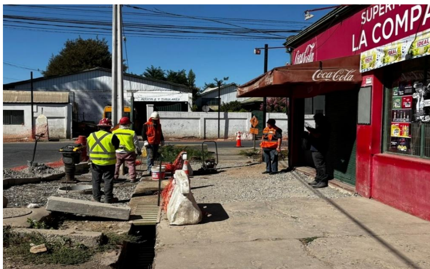
Construcción de semaforización en el cruce de Avenida La Compañía H-15 con H-17
